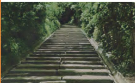
麻布十番にある賢崇寺の改修前の階段 江戸時代に設置されたもので、鍋島藩の菩提寺であるため、殿様を載せた駕籠が大きく傾かないように、段差を小さくし、且つ、一段の奥行きを一步半と大きく取ってある。
