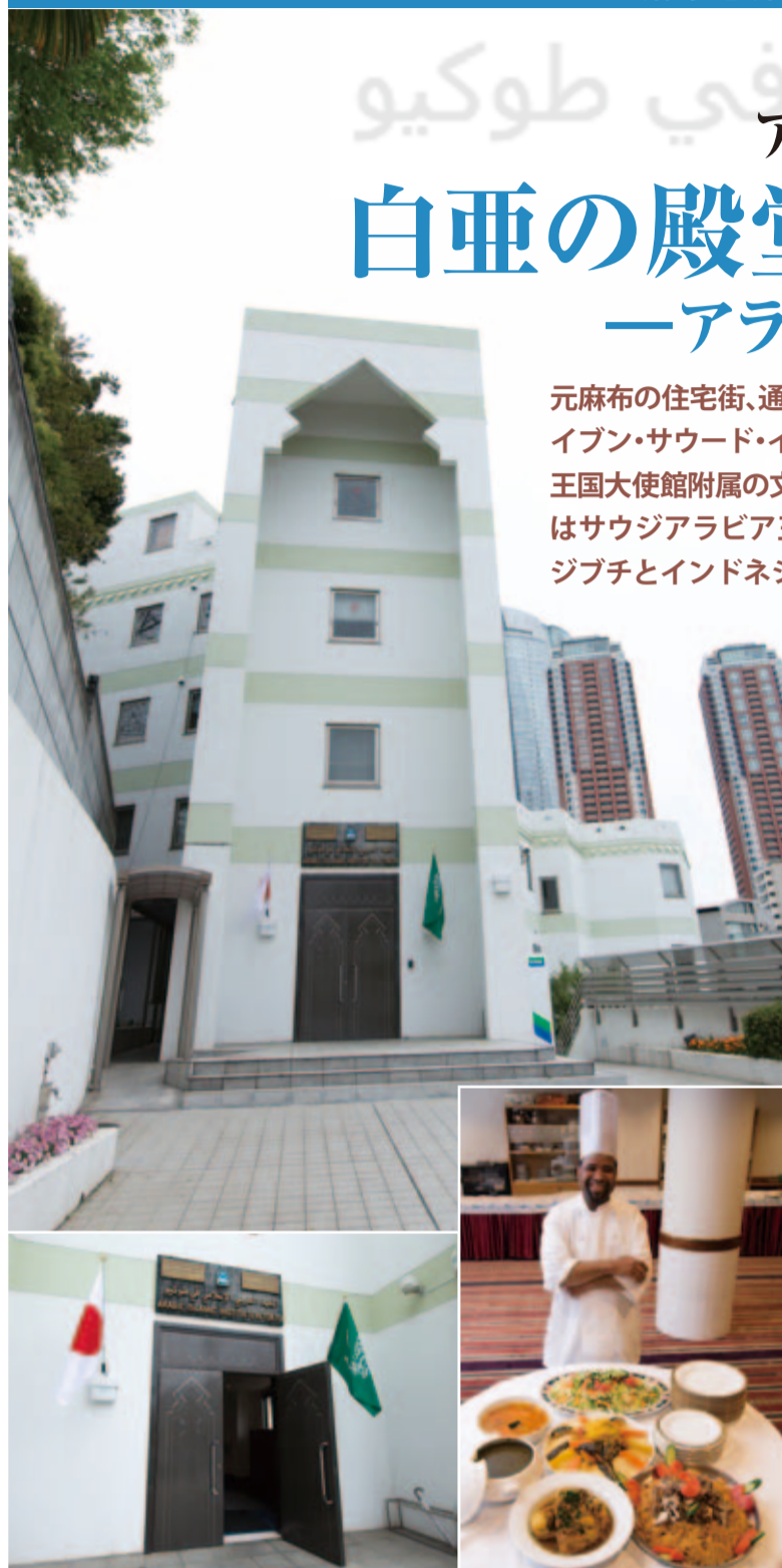
(上)外観は地上4階、地下2階建ての堂々とした白亜の殿堂。 (下)大きな扉には 2カ国の国旗がはためく。
