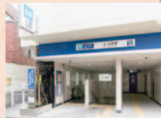
新設された4番出口
