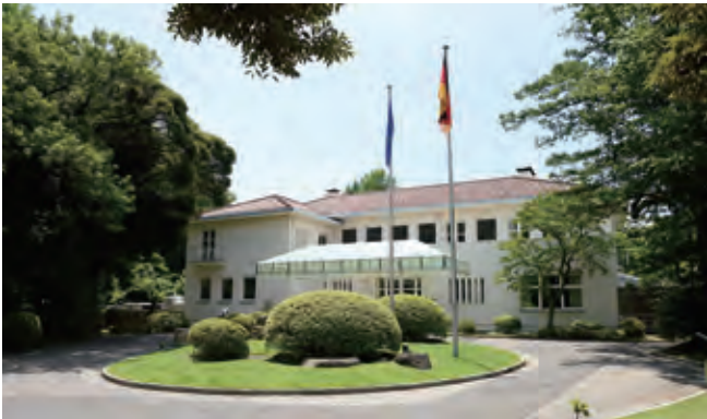
1957年に建てられた大使公邸。設計はドイツと日本の松田平田設計事務所の共同プロジェクトで行われた。
