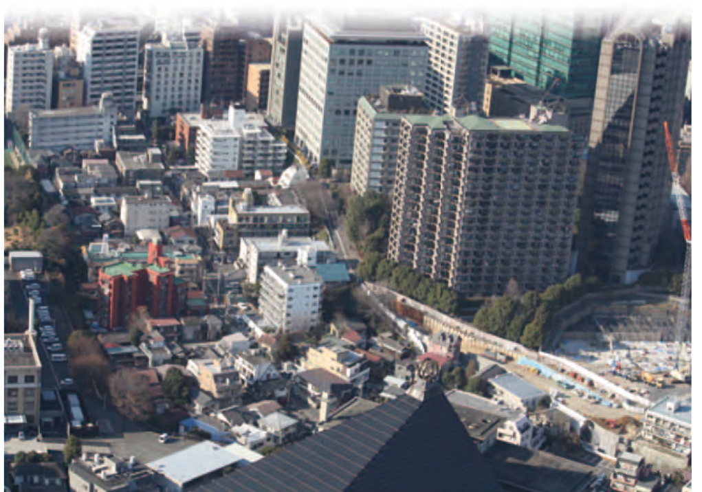
三年坂(麻布我善坊町)周辺全景。右側は建設中のアークヒルズ仙石山森タワー。文字通り再開発の波が押し寄せてきていることがわかる(平成23(2011)年撮影)
