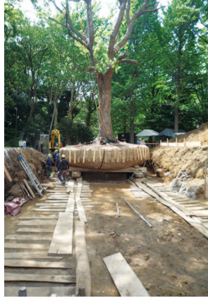
移植工事当日の午後、着地台に到達。手前がコロ、ミチイタによる軌跡。このあと下の井桁状の部材を外し、翌日には完全に土が埋め戻されていた。
