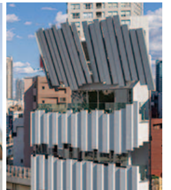
ビル最上階からさらに大空に向かって外壁のALC板が突き抜けるようにそり立つ
