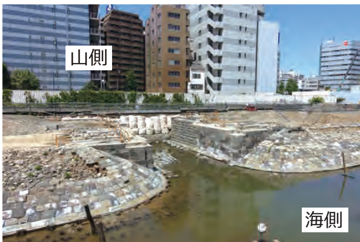
図0-11 この橋梁部では、石材をレンガのように整形して積み、目地材を使って接着している様子も見る事ができる。西洋の考えが取り入れられていると考えられる。
