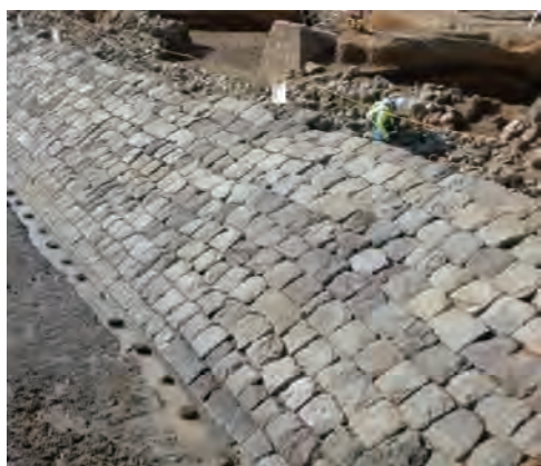
図0-17 明治5年 海側(東)石垣(布積み)
