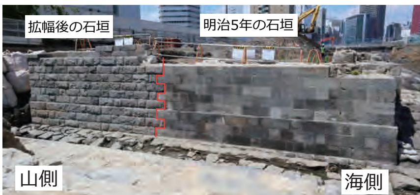
図0-12 石垣の表面を見ると、写真奥（山側）と手前（海側）で仕上げが違えることが確認できる。橋台が山側に拡幅されたことがわかる。
