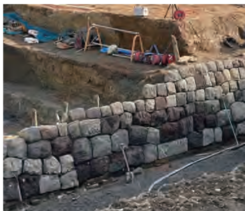
図0-18 明治5年 山側(西)石垣(布積み) 築堤拡幅時に埋められていた。
