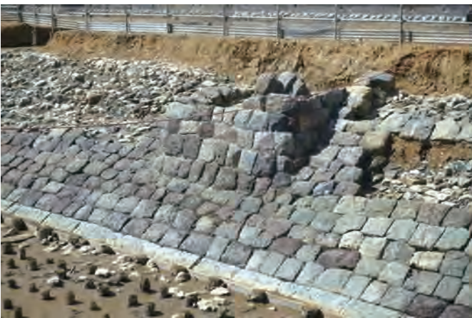
図 0-14 張り出し部分が土台となり、この上に柱状の信号機が設置されていたと考えられる。
