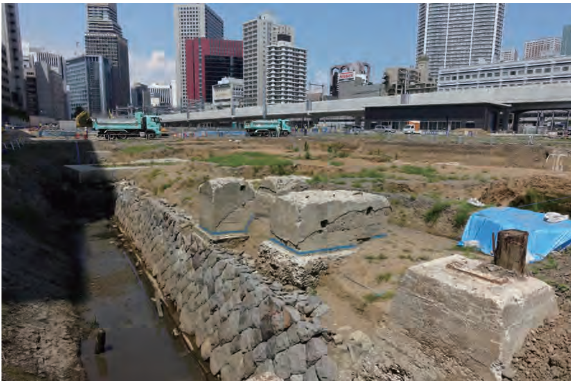
口絵6 築堤拡幅後の山側(西)の石垣(石垣上部のコンクリートは、架線柱や高架橋の跡)
