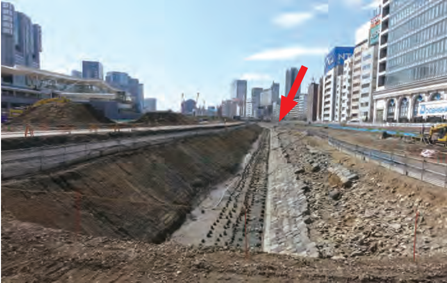
図 0-13 4 街区（高輪ゲートウェイ駅前）から出土した信号機跡の位置（北から）
