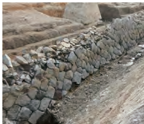
図0-20 拡張後 山側(西)石垣(谷積み)
