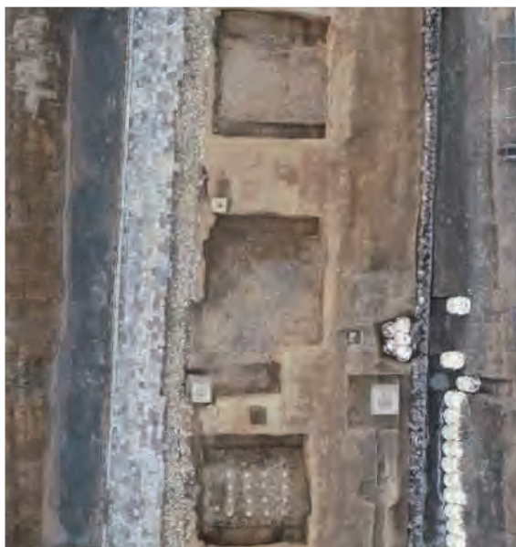
図0-19 上空から見た築堤。左側(東)が明治5年の海側石垣。右側(西)が山側、拡幅後の石垣。
