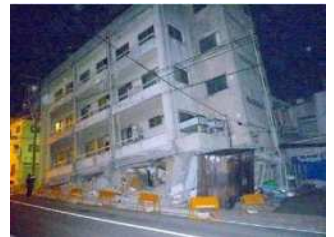
▲建物被害の状況
