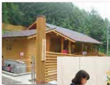
みなと区民の森 環境学習施設 (作業小屋)
