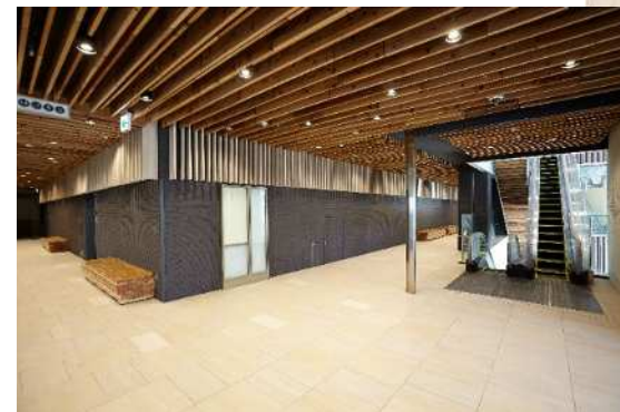
店舗部の共用部にはスギ材のベンチと天井ルーバー
