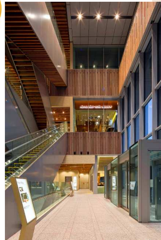
店舗部の吹抜壁面及びエスカレーター部にスギ材を使用したルーバー
