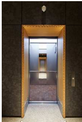
EVの三方枠にスギ材を使用し、表面には「名栗」の加工 天井部には広葉樹丸太を意匠として設置
