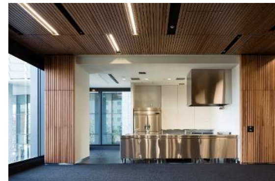
コミュニティホール 壁・天井仕上 (スギ/宍粟市)
