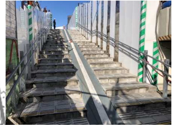
斜路付階段部通路
