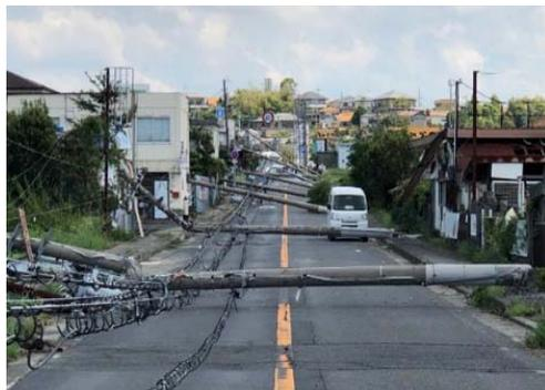
写真1-1 台風による電柱の倒壊状況
