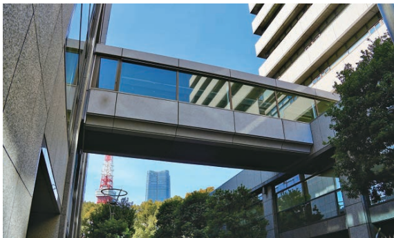
庁舎と議場を連絡する上空通路
