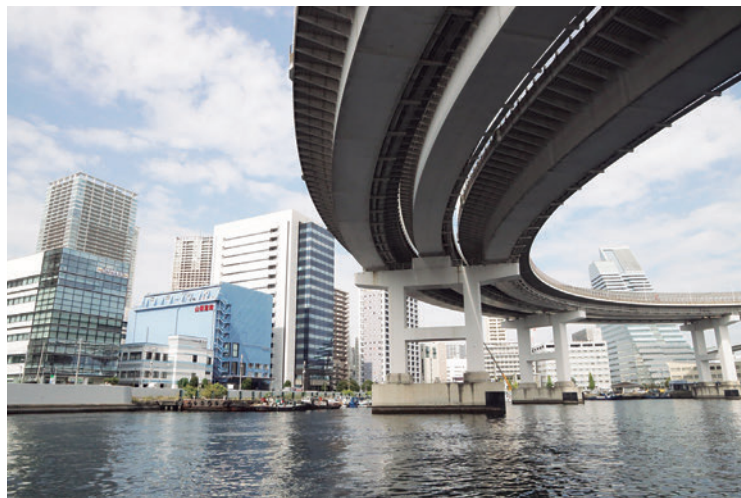
橋 | BRIDGE 都市と水辺
