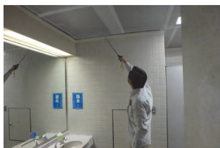
建築基準法に基づく点検
