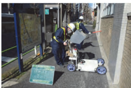
道路下空洞調査
