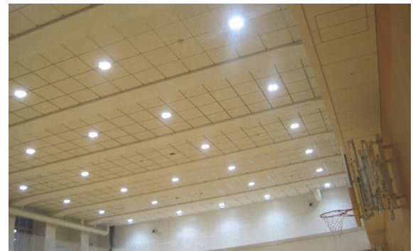
軽量化した天井材に変更した様子
