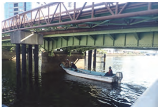
台船から橋脚の状況を確認
