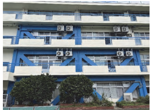
耐震改修工事の事例
