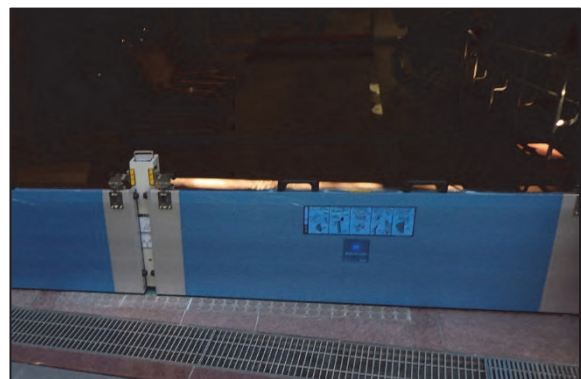
止水板を設置した様子
