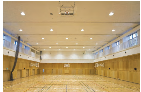
改修工事前の様子
