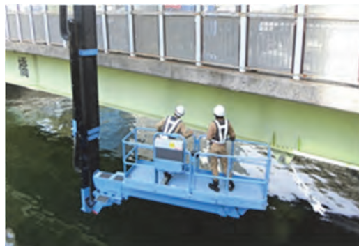
リフト車により、橋桁の状況を確認
