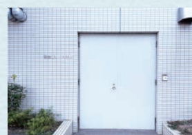
台場区民センターの備蓄倉庫
