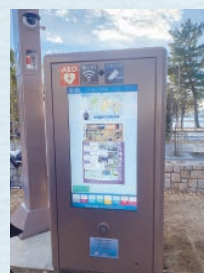
区立お台場レインボー公園のスマートポール。公衆無線LANに加え、デジタルサイネージや防災スピーカー、AEDなどの多様な機能を備えたもの
