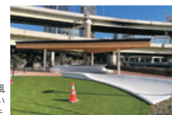
運河沿いの風 が気持ち良い ウッドデッキ
