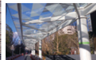
外構工事の様子（2月下旬）
