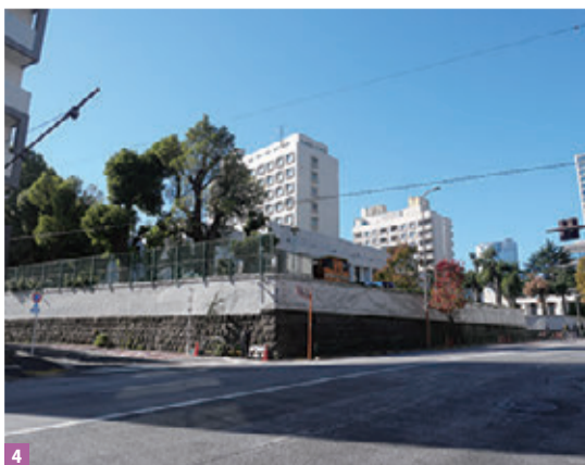
4 現在のロシア連邦大使館、敷地の上は空が広い
