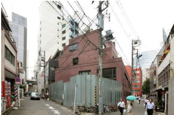
②街区中央付近
