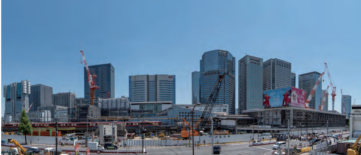
▲品川駅西口の工事の状況（令和8（2026）年5月17日撮影）
