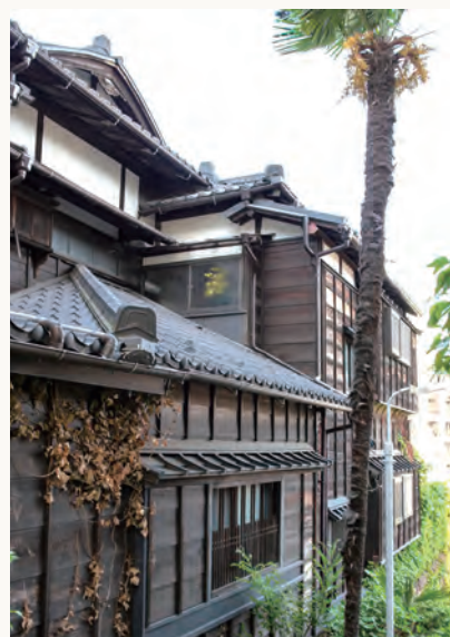
下見板張で仕上げられた、南側の路地から見た外観
