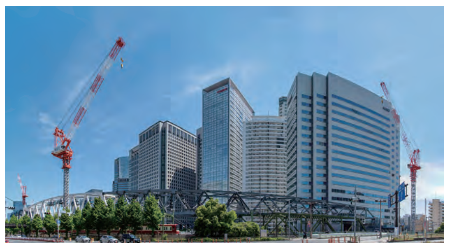
▲八ツ山跨線橋の架け替え工事の状況（令和8（2026）年5月5日撮影）
