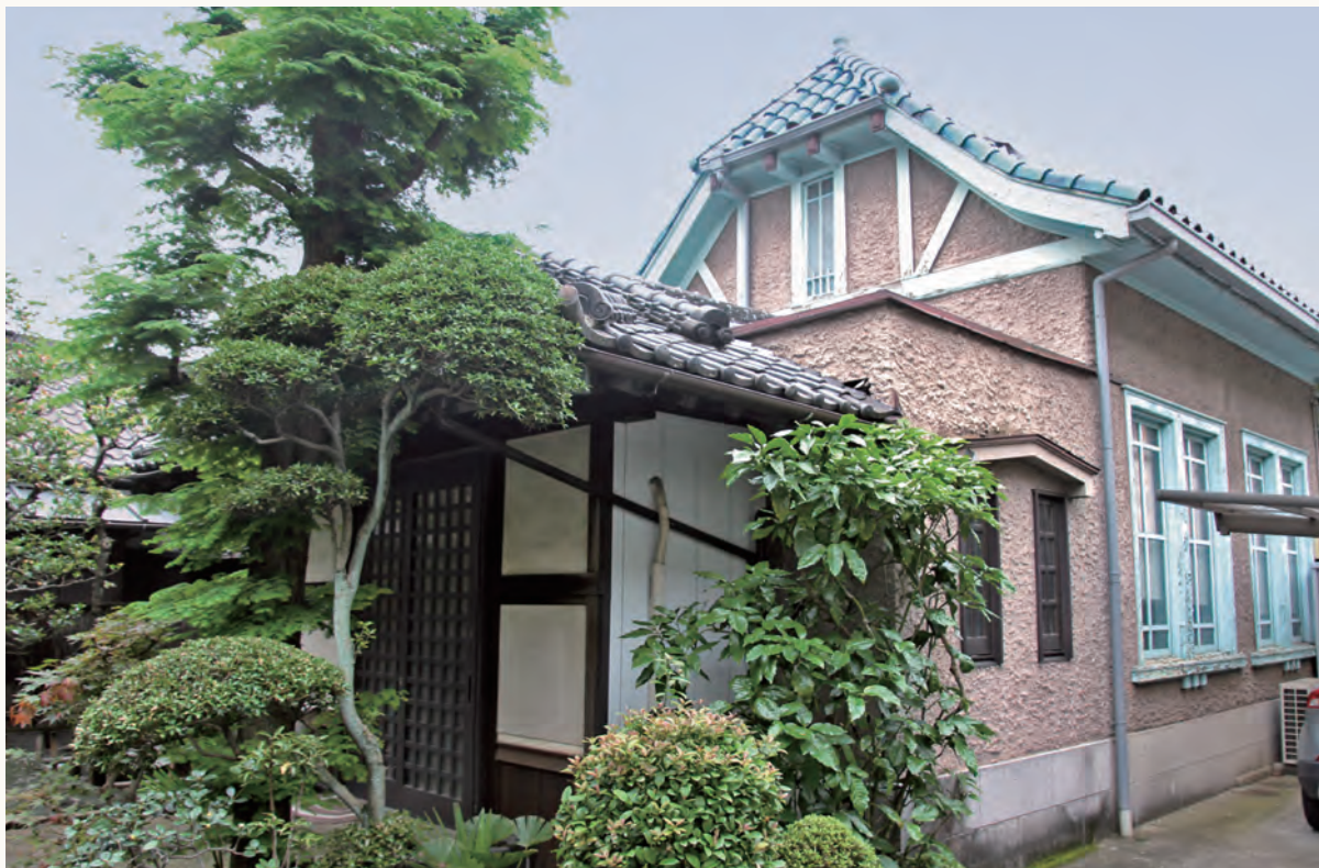
玄関が和、診療室部分が洋、という和洋折衷の外観。洋館部分の薄いブルーの屋根の形状や窓枠が印象的
