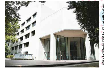
東京都立中央図書館外観
