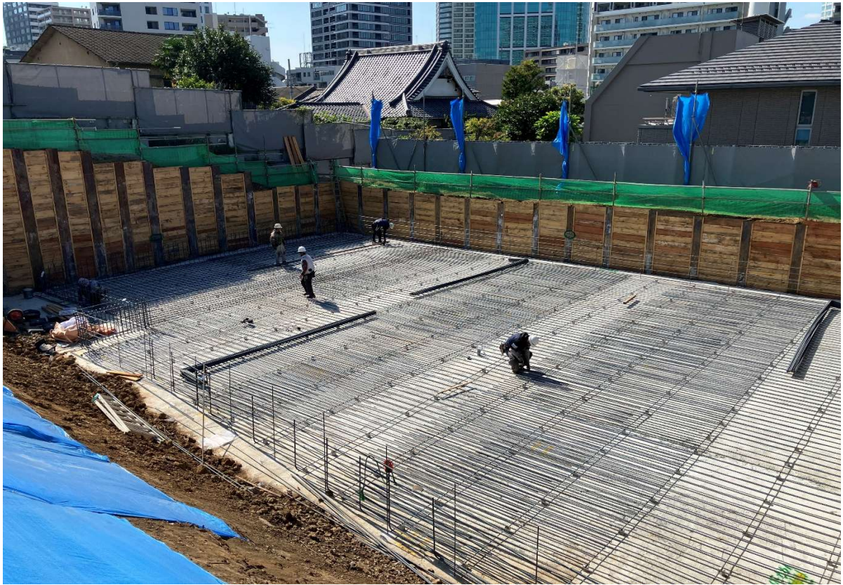
撮影月日 令和7年9月1日 写真説明 人工地盤1 施工状況
