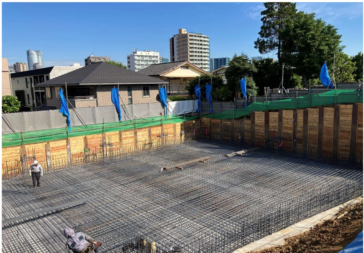
撮影月日 令和7年9月3日 写真説明 人工地盤1 施工状況
