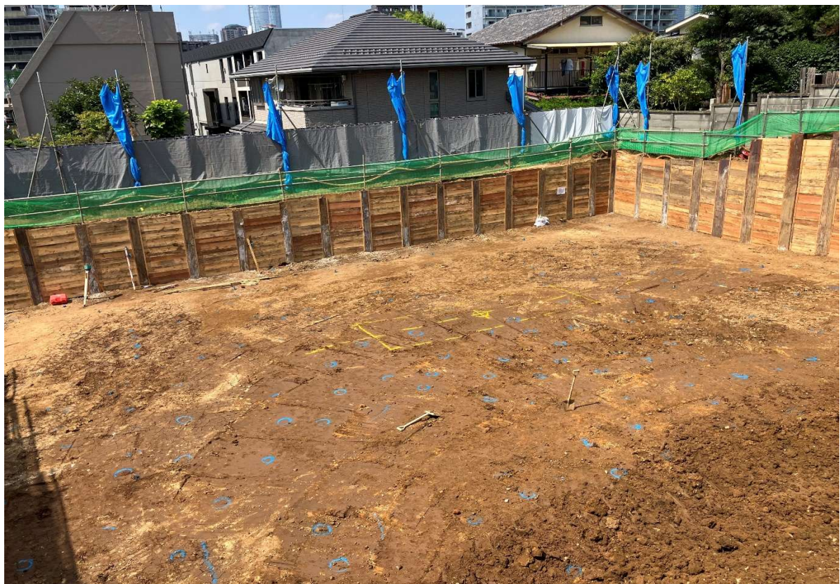
撮影月日 令和7年8月25日 写真説明 人工地盤1 施工状況
