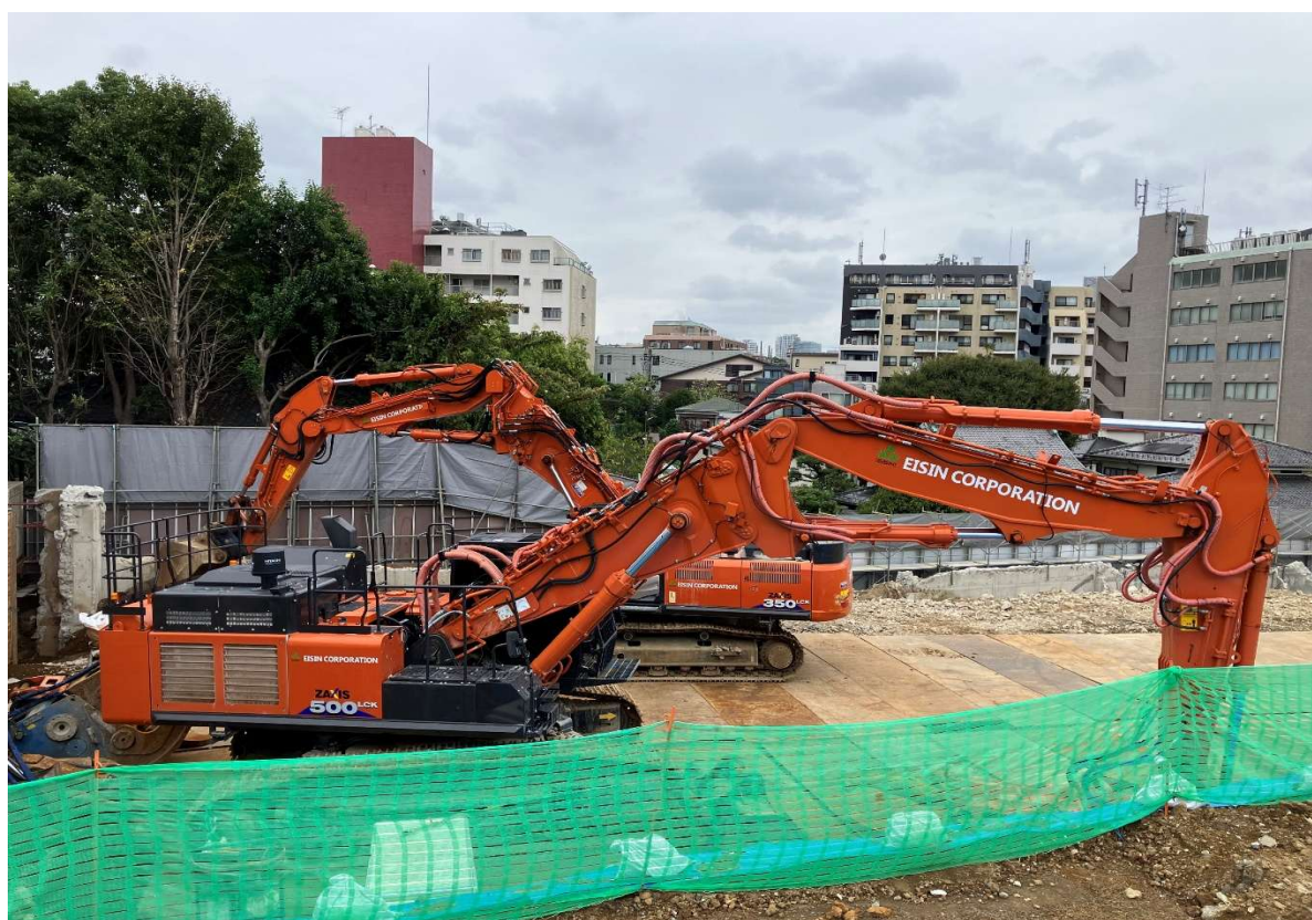
撮影月日 令和7年10月14日 写真説明 既存校舎解体状況
