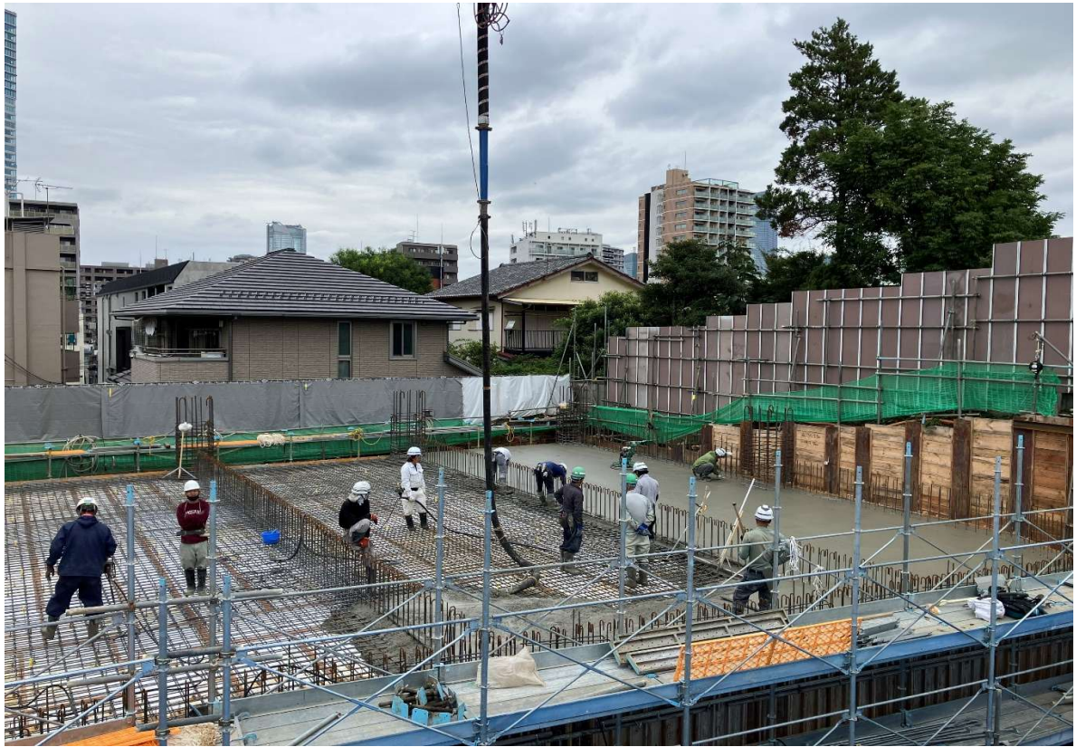
撮影月日 令和 7 年10月21日 写真説明 人工地盤 1 施工状況
