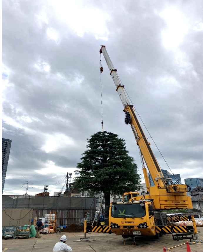
撮影月日 令和7年10月27日 写真説明 ヒマラヤスギ移植状況
