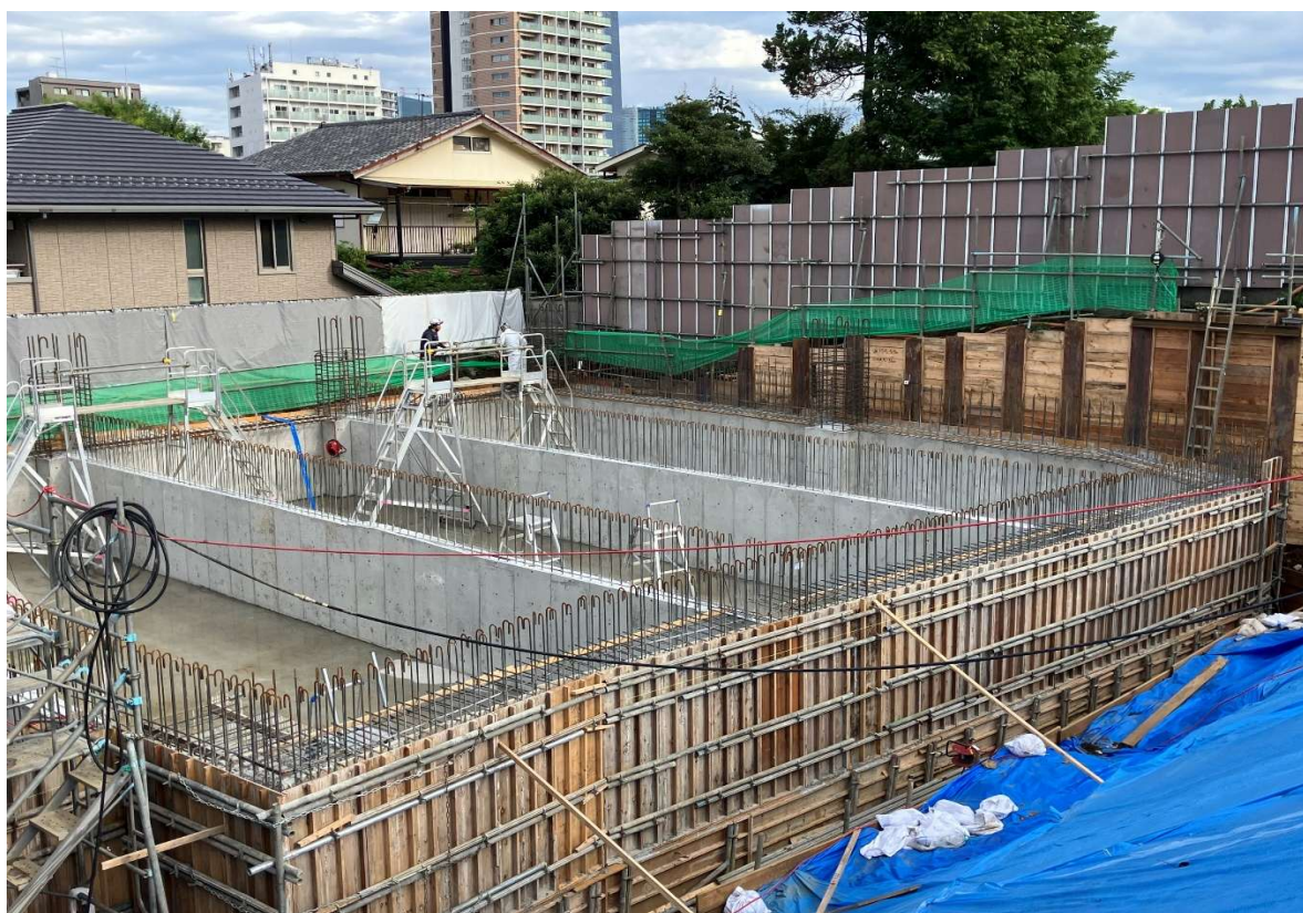
撮影月日 令和7年10月6日 写真説明 人工地盤1 施工状況
