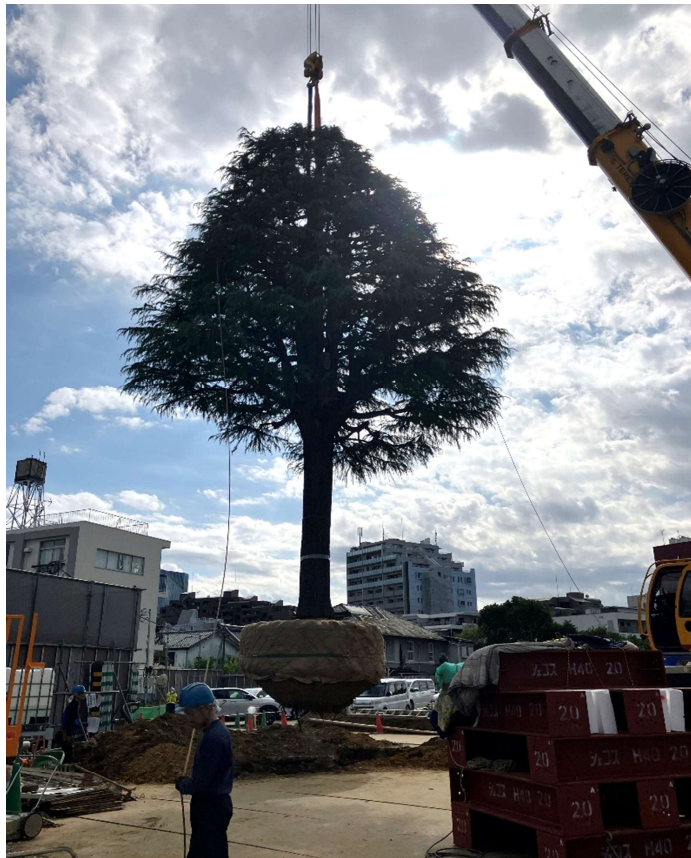
撮影月日 令和7年10月28日 写真説明 ヒマラヤスギ移植状況
