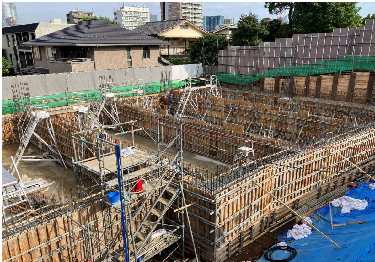
撮影月日 令和7年10月2日 写真説明 人工地盤1 施工状況
