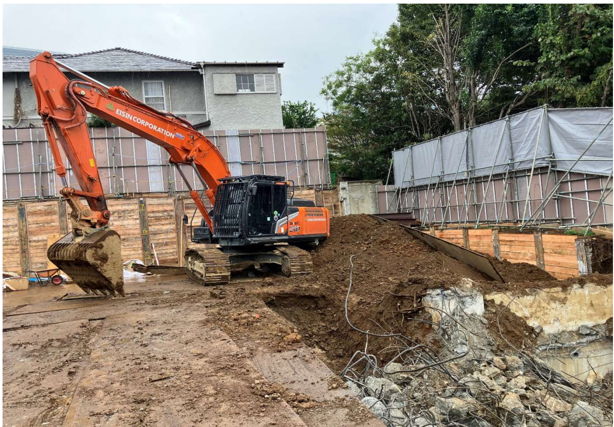
撮影月日 令和 7 年10月22日 写真説明 既存校舎解体状況
