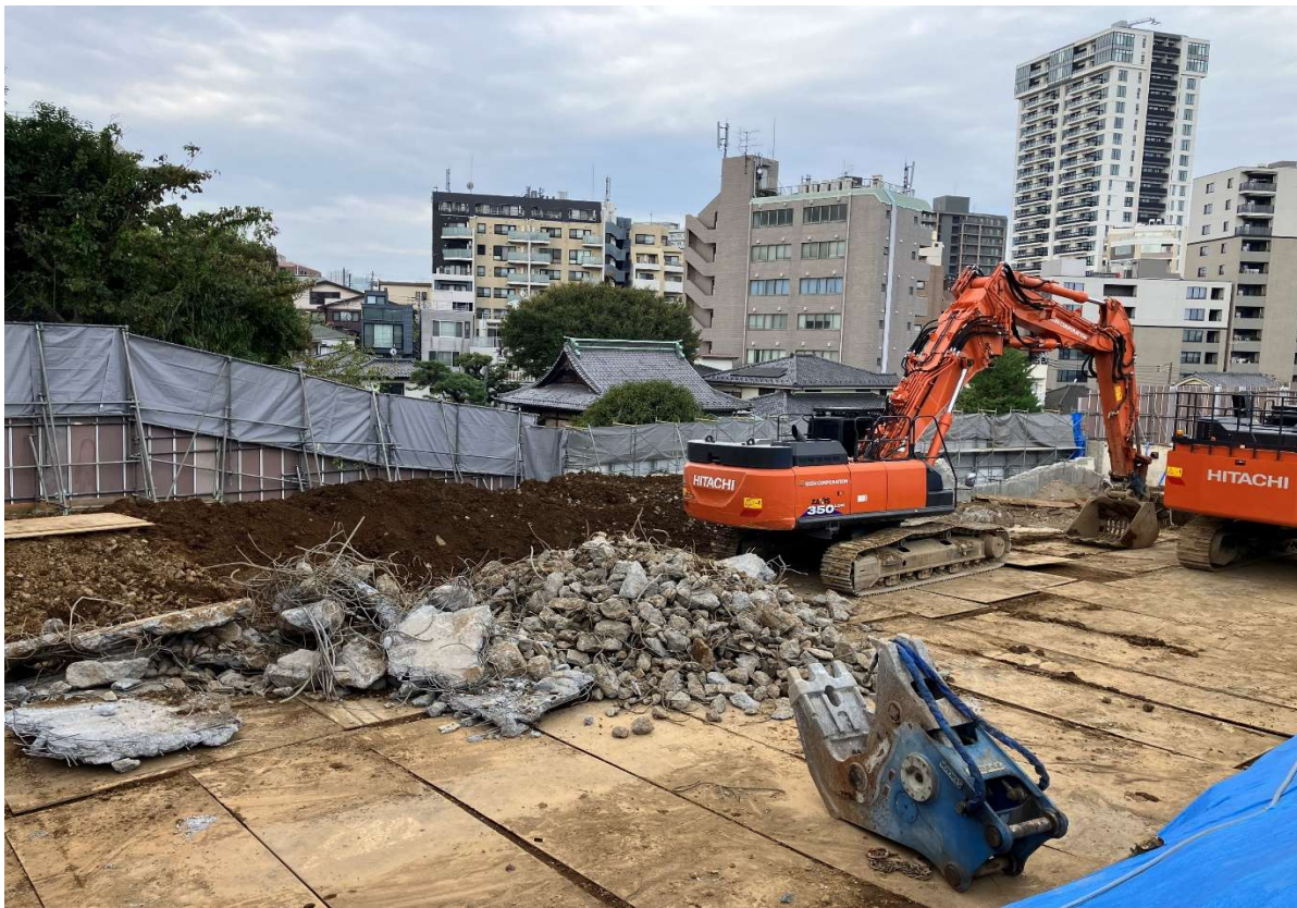
撮影月日 令和7年10月31日 写真説明 既存校舎解体状況
