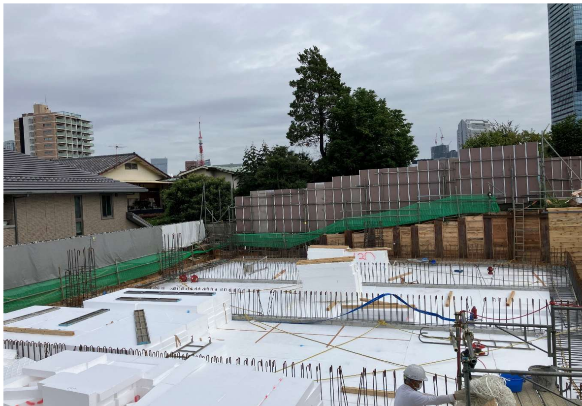
撮影月日 令和7年10月10日 写真説明 人工地盤1 施工状況
