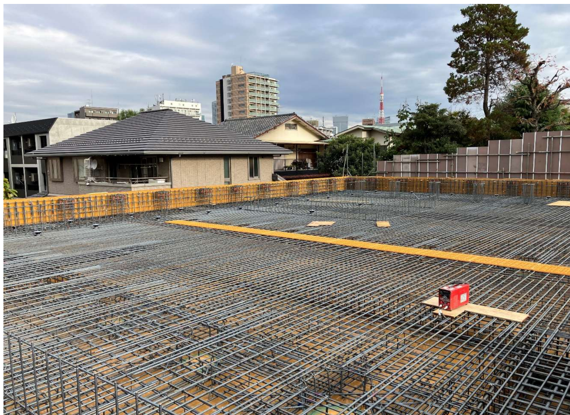
撮影月日 令和7年11月20日 写真説明 人工地盤1 施工状況
