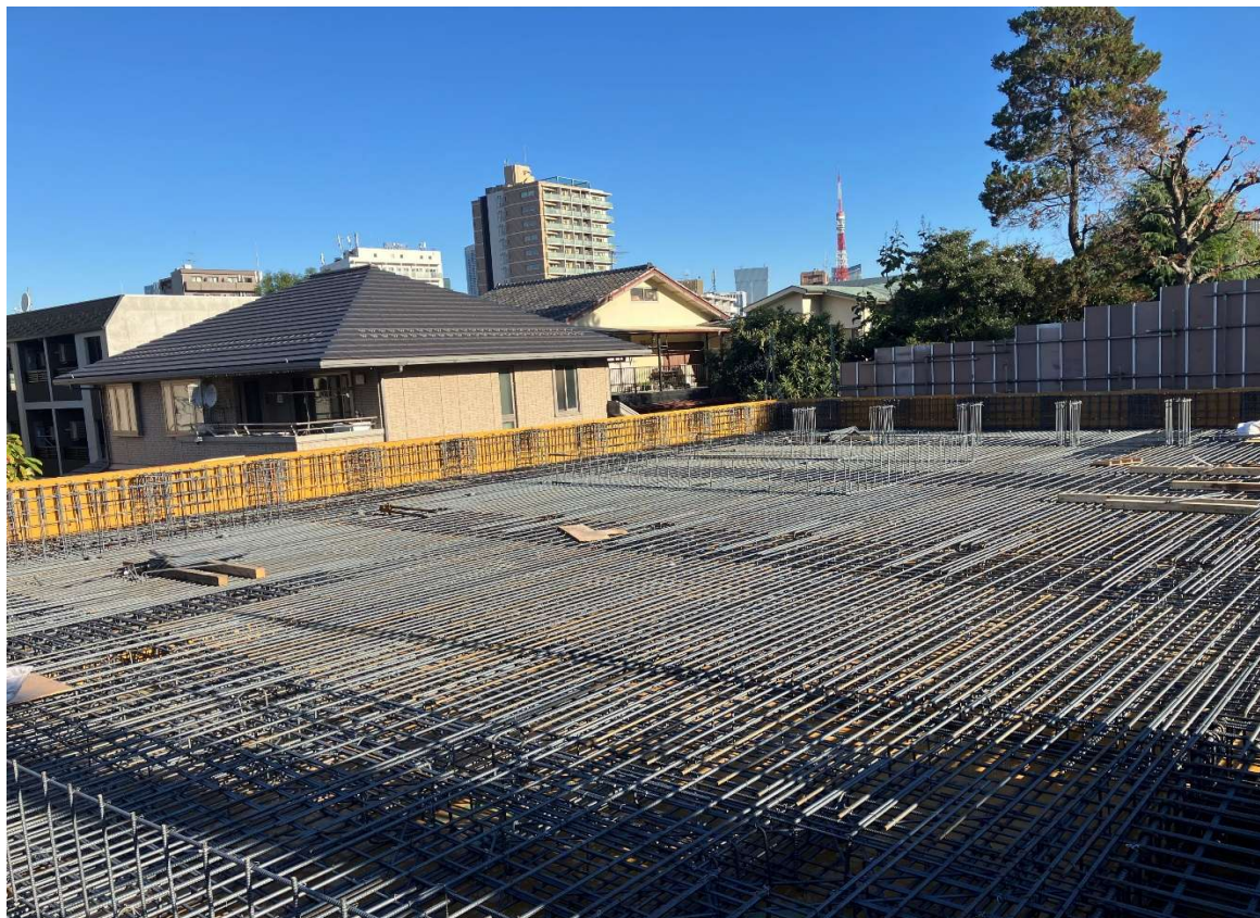
撮影月日 令和7年11月19日 写真説明 人工地盤1 施工状況
