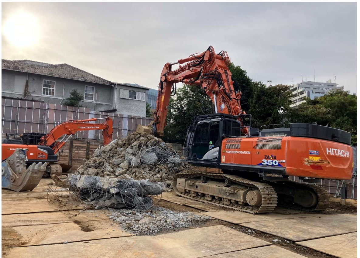
撮影月日 令和7年11月5日 写真説明 既存校舎解体状況
