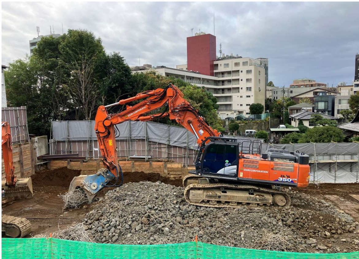
撮影月日 令和7年11月6日 写真説明 既存校舎解体状況
