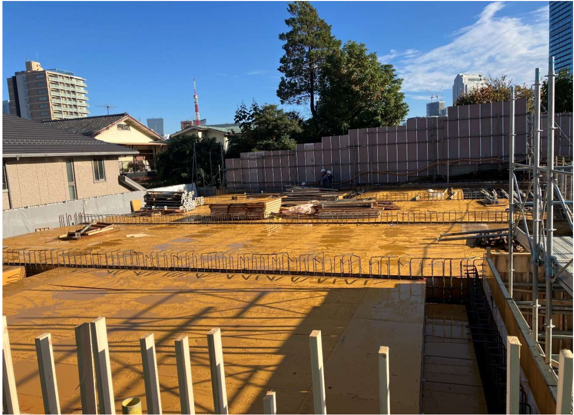
撮影月日 令和7年11月10日 写真説明 人工地盤1 施工状況
