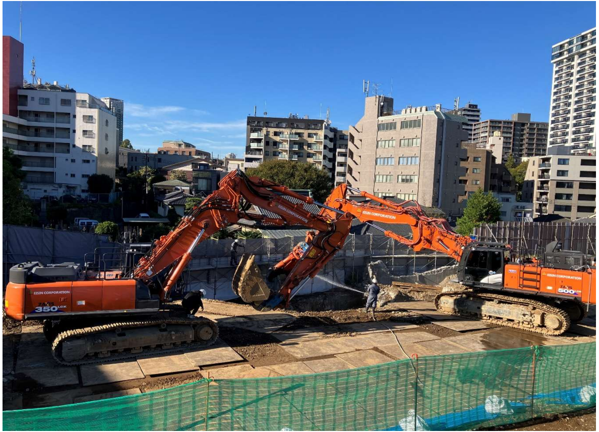
撮影月日 令和7年11月4日 写真説明 既存校舎解体状況
