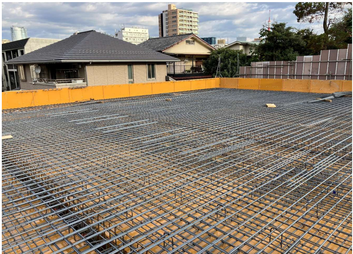
撮影月日 令和7年11月18日 写真説明 人工地盤1 施工状況
