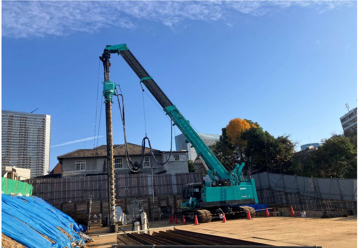
撮影月日 令和7年12月8日 写真説明 既存校舎解体状況
