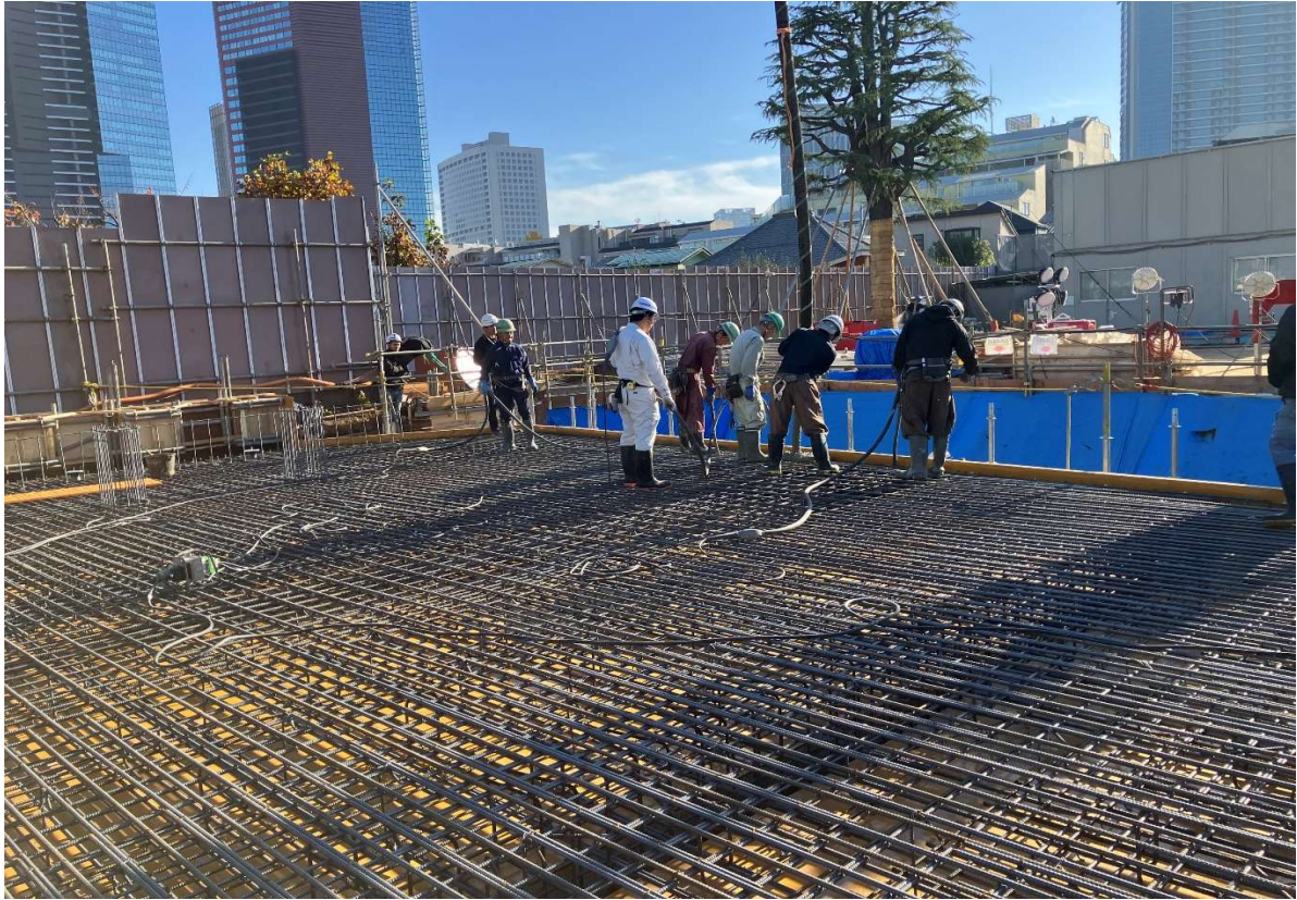
撮影月日 令和7年12月1日 写真説明 人工地盤1 施工状況
