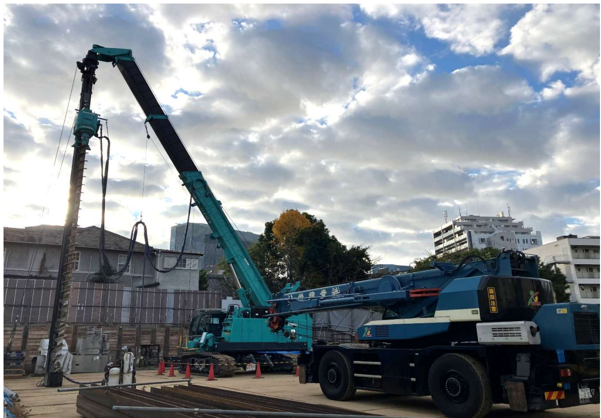
撮影月日 令和7年12月9日 写真説明 既存校舎解体状況
