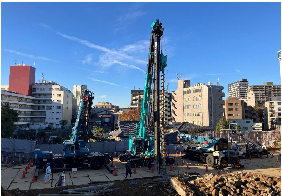
撮影月日 令和7年12月10日 写真説明 既存校舎解体状況
