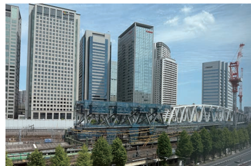
整備が進む大規模な鉄橋
