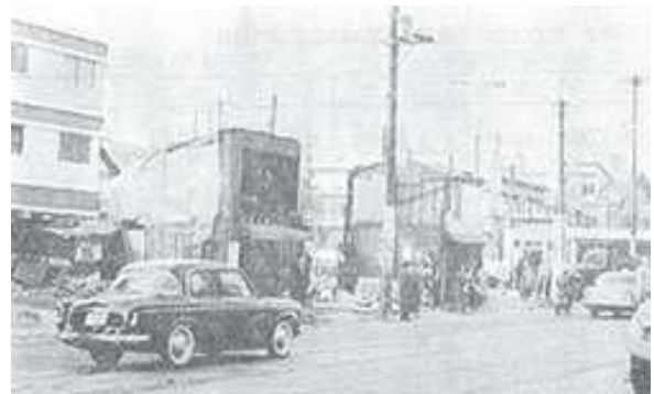
■ 拡張工事中の青山通り （昭和 38（1963）年） 出典：『新修港区史』
