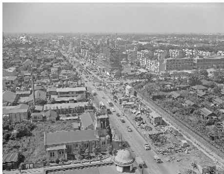
■ 拡張工事中の青山通り（広域） （昭和38（1963）年）
