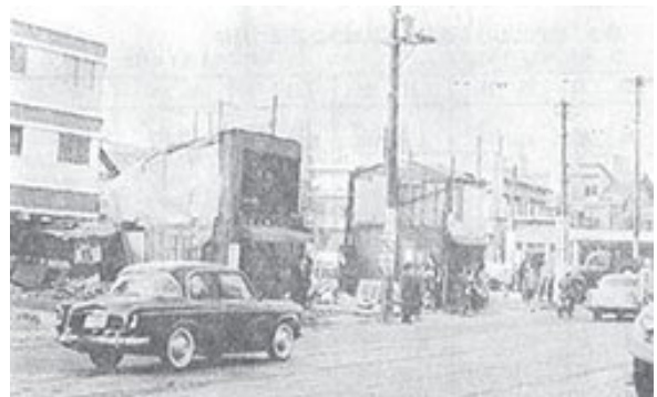
■ 拡張工事中の青山通り （昭和38（1963）年）
