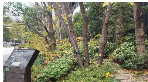
▲水害対策のための雨水浸透グリーンインフラ (ポートシティ竹芝のレインガーデン)
