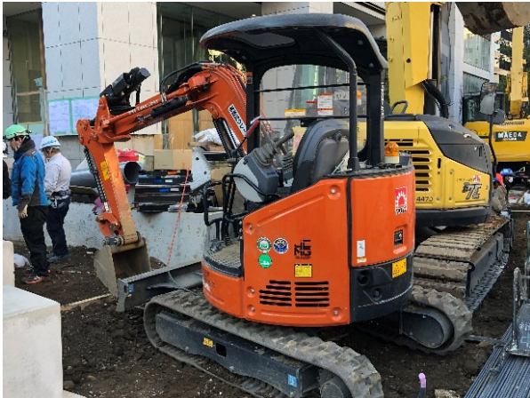
写真 4. 6. 1-1 低騒音型建設機械の使用状況
