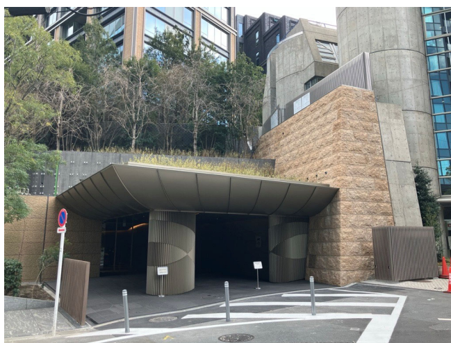
写真 4. 5. 2-3 沿道掘削に該当する地下通路エントランス部の完成状況
