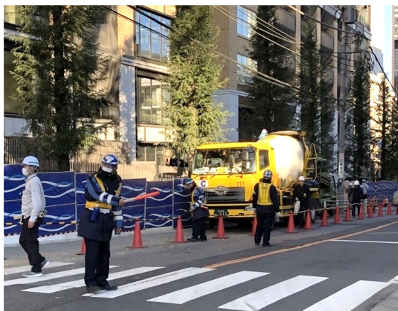
写真 4. 1. 1-2 工事用車両出入口における交通整備員の配置状況
