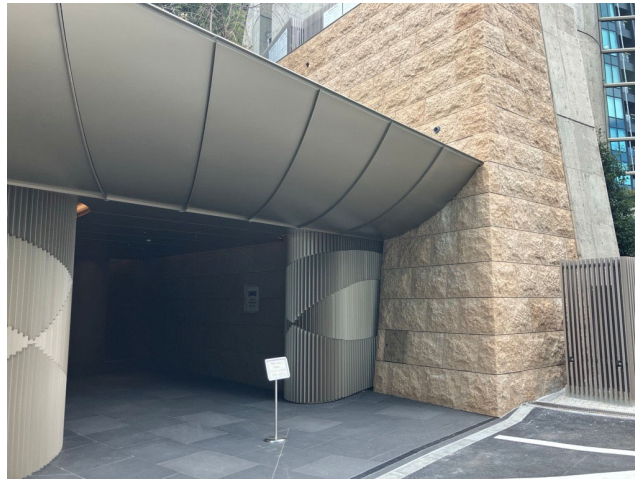
写真 4. 5. 2-4 沿道掘削に該当する地下通路エントランス部の完成状況
