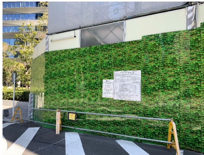
写真 4. 6. 1-2 仮囲い、防音パネルの設置状況
