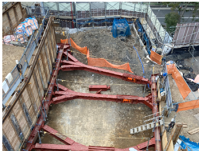
写真 4. 5. 2-1 山留工事（親杭横矢板工法）と切梁支保工の実施状況
