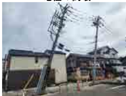
電柱の倒壊
