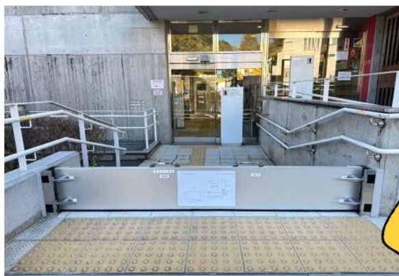
区有施設における止水板の設置例
