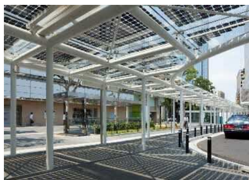
太陽光発電パネルを設置した タクシーシェルター（川崎駅東口）
