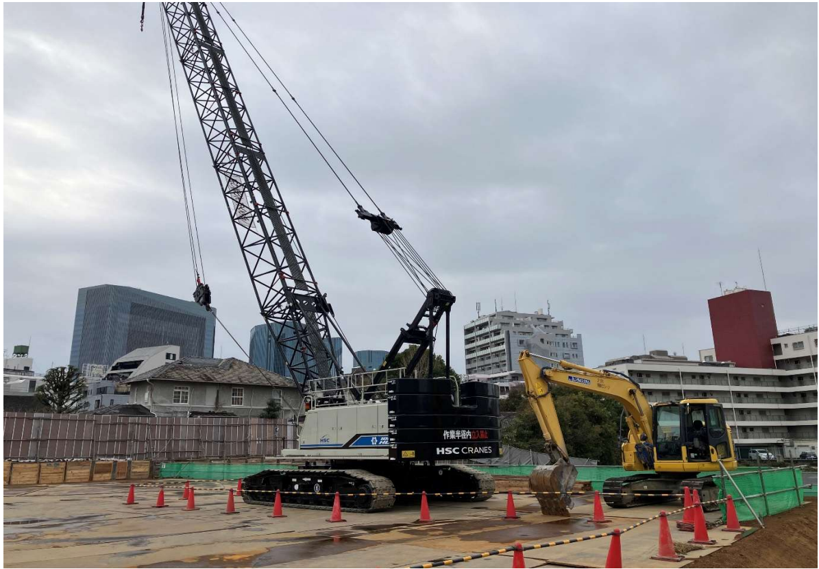
撮影月日 令和8年2月17日 写真説明 新校舎建築状況
