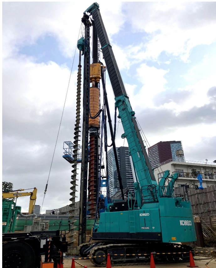
撮影月日 令和8年2月24日 写真説明 新校舎建築状況
