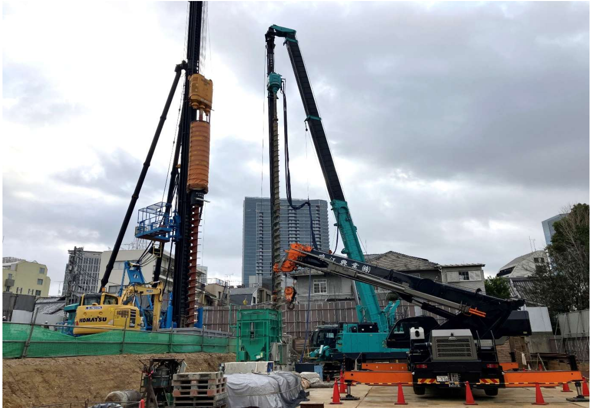
撮影月日 令和8年2月24日 写真説明 新校舎建築状況
