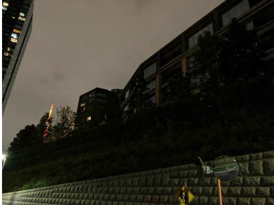
特別区道第 823 号線沿いの状況（計画地西側） （撮影日：令和 7 年 11 月 18 日（火））
