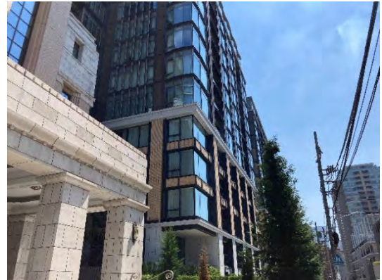
④立面を3層構成で デザインすることにより、壁面を分節。 また低層部は、石材やタイルを使用。
