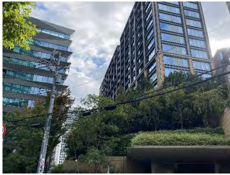
①敷地北側の緑化状況
