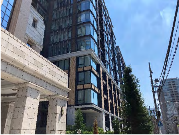
外装材の状況
