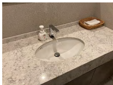
写真 4.10.1-3(2) 節水型の採用（自動水栓）
