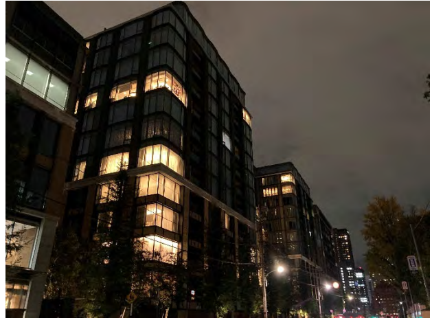
特別区道第 1023 号線沿いの状況（計画地南側） （撮影日：令和 7 年 11 月 18 日（火））
