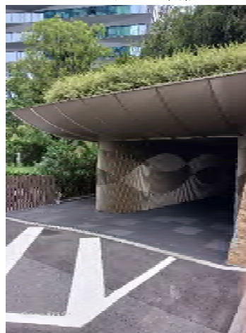
出入口付近の庇
