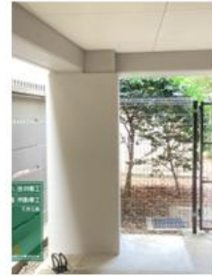
柱の鋼板巻きの施工
