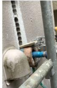
部分スリットの施工
