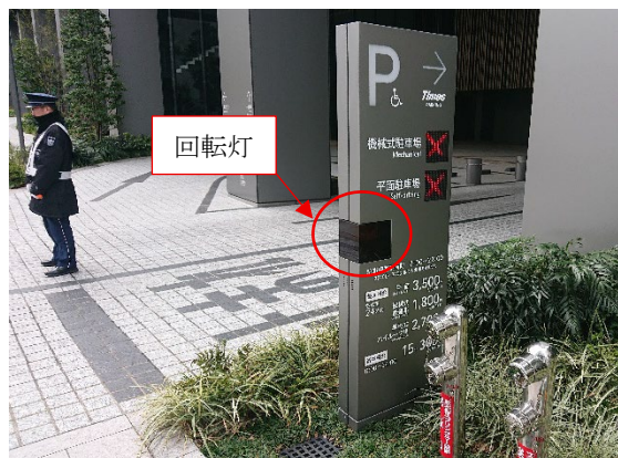
写真 4.1.5-1 駐車場出口の状況 (出庫ブザー、回転灯、路面標示、誘導員)
