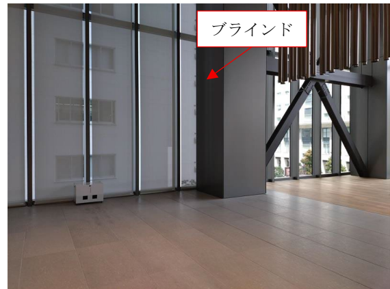
写真 4. 15. 2-2 ブラインドの設置状況
