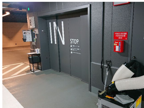
写真 4.1.3-2 駐車場の状況（機械駐車）
