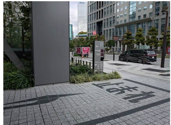
写真 4.1.5-2 駐車場出入口の状況 (一時停止の路面標示)
