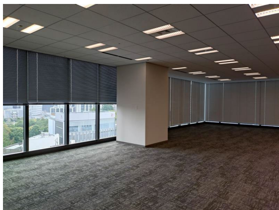
写真 4.3.2-1 LED 照明の設置状況
