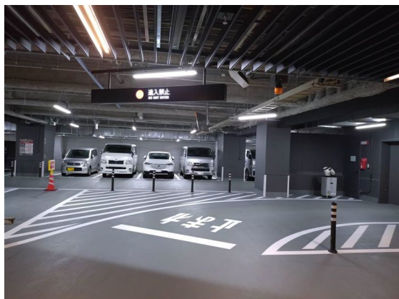
写真 4.1.3-1 駐車場の状況（地下 2 階）
