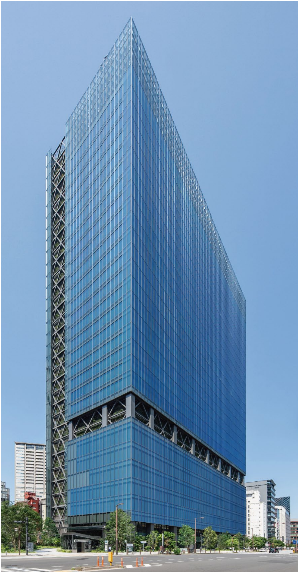
写真 2.3.2-1 竣工写真（計画地を北東側より望む）
