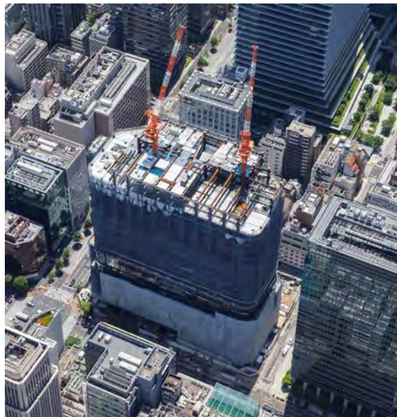
地上鉄骨・躯体工事（令和8年5月撮影）
