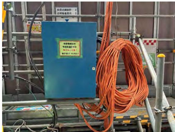
写真4.3.1-4 山留壁の計測・管理状況
