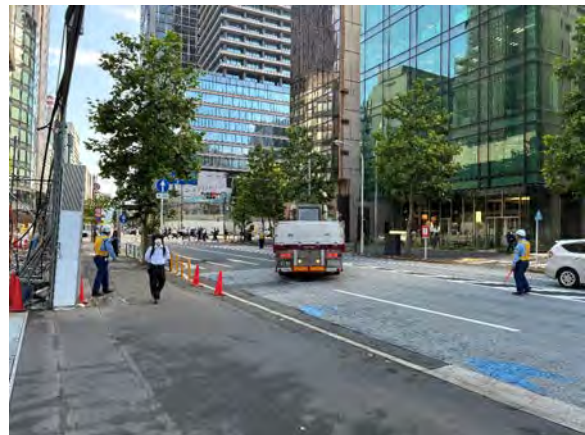
写真4.1.1-3 交通誘導員の配置
