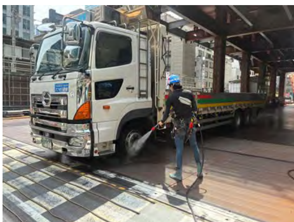
写真4.2.1-5 タイヤ洗浄の状況
