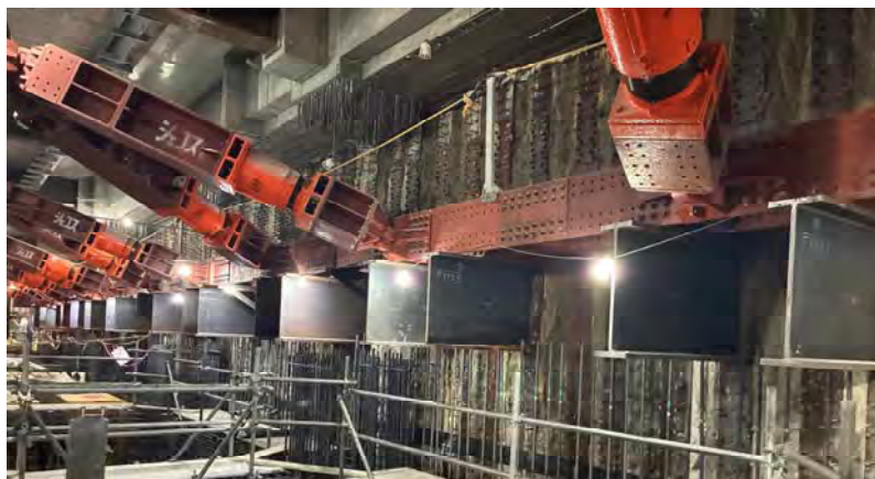
山留壁(SMW)・切梁
