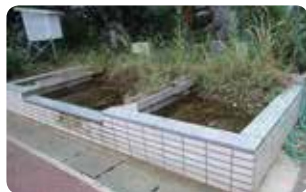
御田小学校のビオトープ
