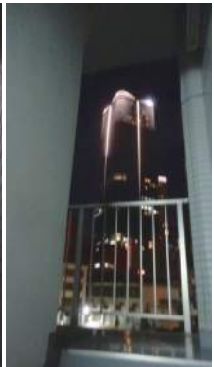
写真4 麻布台ヒルズ・深夜そびえ立つ 撮影：2024年2月9日（金）
