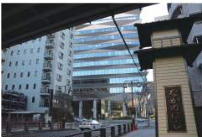
令和6年(2024年)1月・上屋敷跡、西北端の地のいす 古川をはさんで、森町街から中之橋の向こうを望む。水天宮がまつられていたと思われる有馬堂 上屋敷跡の西北端にある場所には、現在、近未来的な外観のオフィスビルが建っている(写真 参照)
