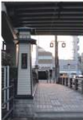
令和6年(2024年)11月:中之橋の欄柱 欄柱には、有馬家上屋敷に掛けられていたもう一つの名物、大の足増のデザインが施されている。
