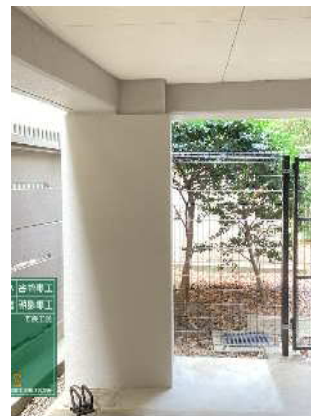
柱の鋼板巻きの施工
