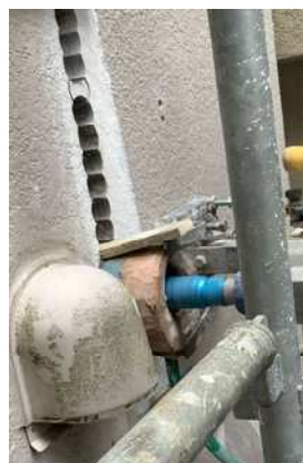
部分スリットの施工
