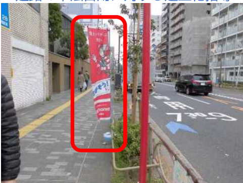
不法占用物の指導（民地内への移設） 〈東京国道事務所 一般国道1号（桜田通り）〉
