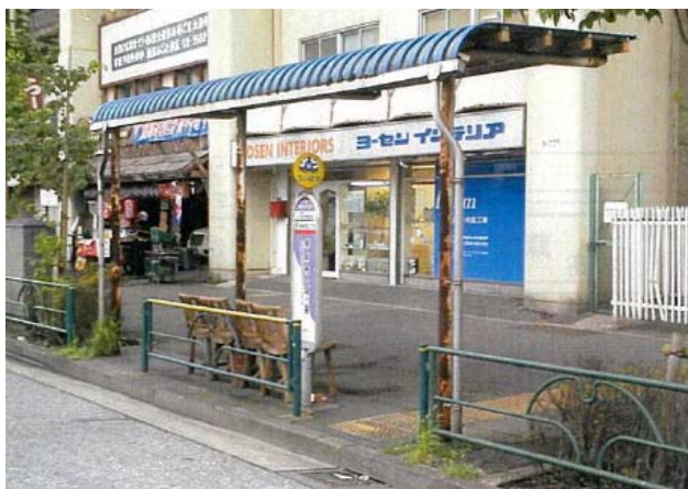
87 東麻布二丁目（設置前）
