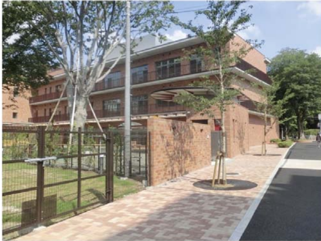
南麻布4丁目に整備された麻布中高生プラザ
