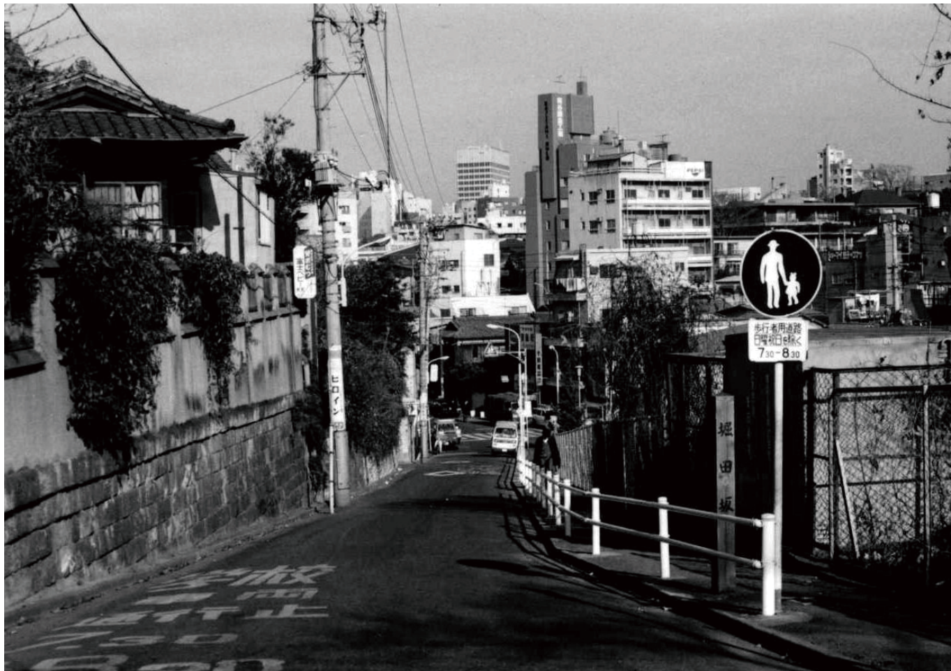
昭和 49年(1974年)：堀田坂 坂上から
