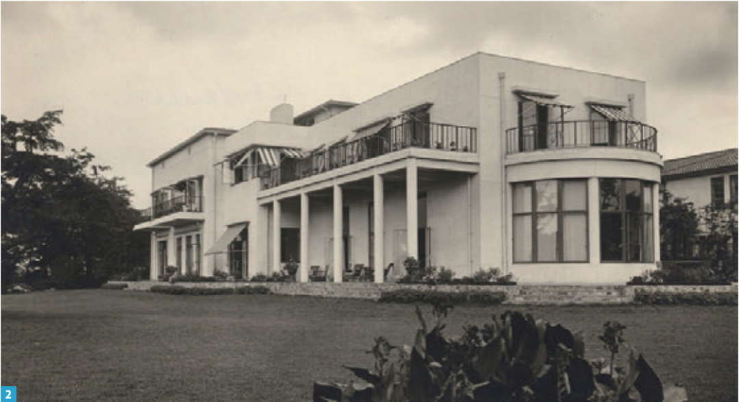
アントニン・レイモンド設計の建物外観、庭園に面して大きく開かれたファサード(正面)
