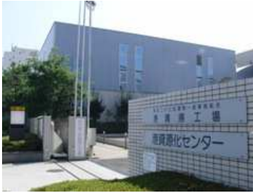
港資源化センターの外観
