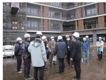
赤坂中学校等整備工事の現場確認
