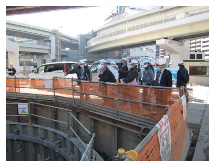
一の橋公園整備工事の現場確認
